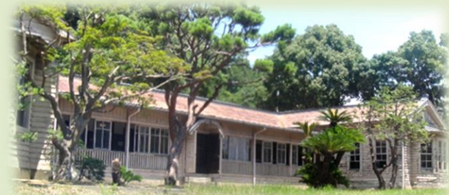
明治期の面影を残す検疫資料館(旧一号停留所) 所在:長浜検疫所敷地内
